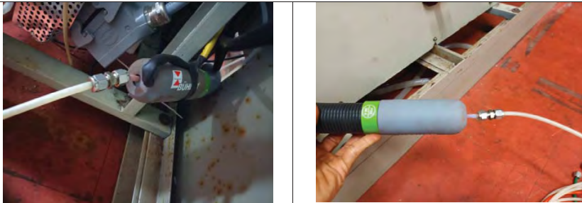
ใช้ instrument air เป่าทำความสะอาด Heated line 45M / 2M
